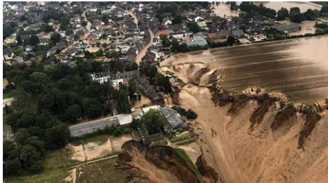
Hochwasserschutz und Wasserspeicher
